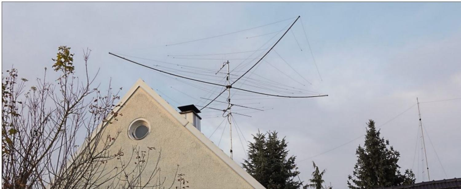
Auf seinem Dach hat Christian Frankl eine zehn mal zehn Meter große Richtantenne. Eine sogenannte „Spiderbeam“.
