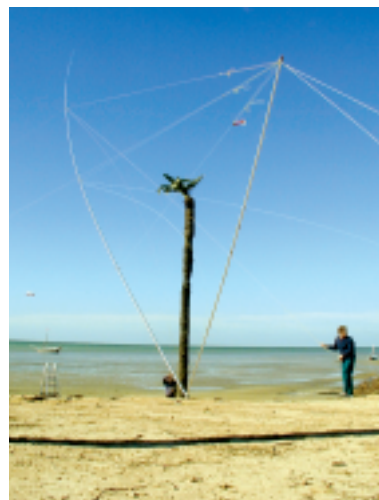
Beim Aufrichten einer 21 m hohen Vertikal für 80 m
