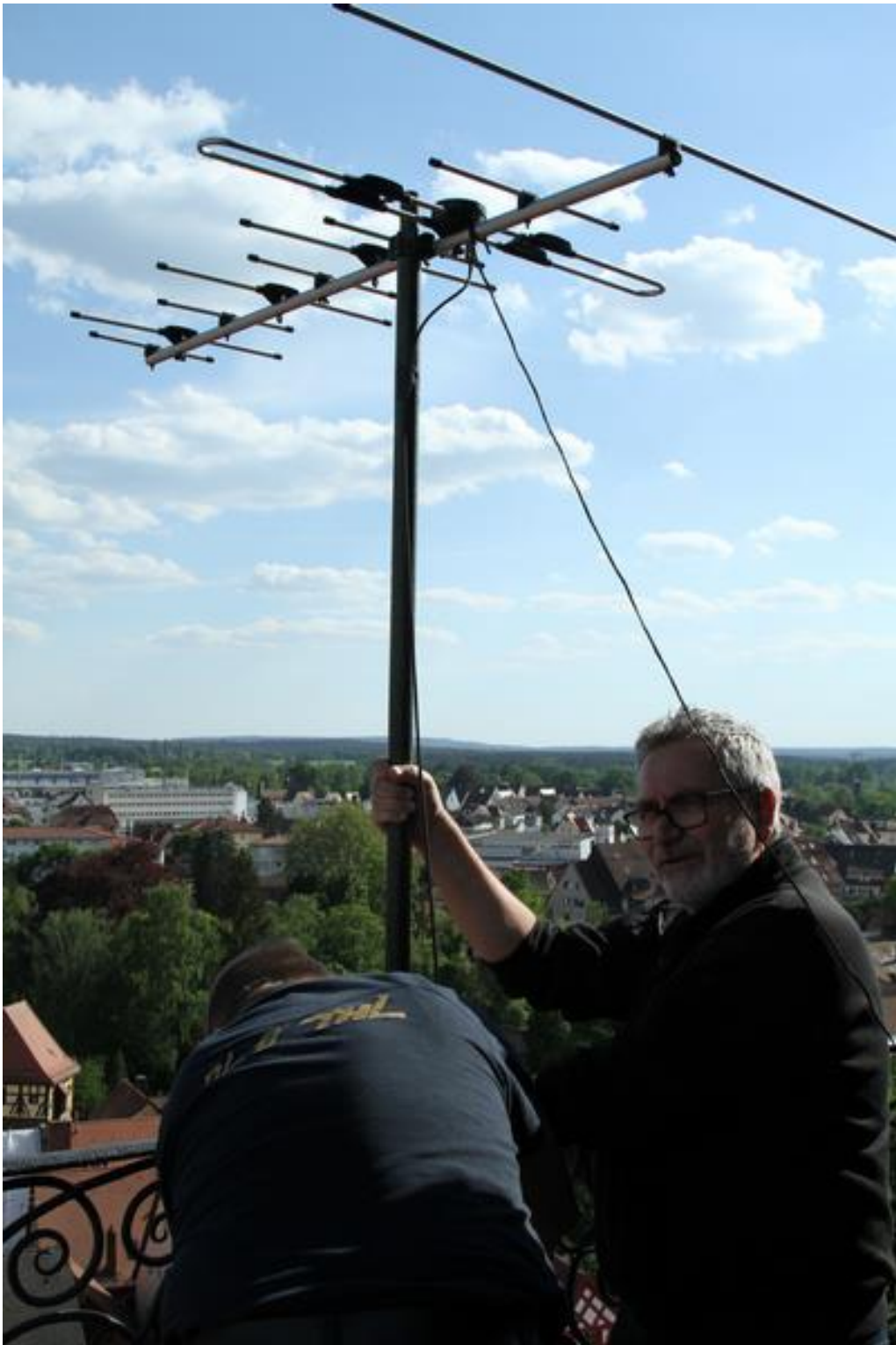
Ausrichten der Antenne
