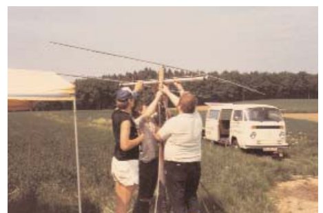
Aufbau der HB9CV für 10m an einem 10m Kurbelmast
