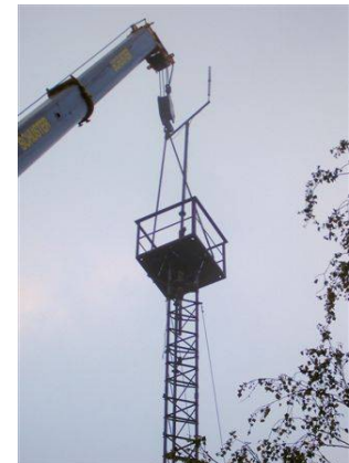
Der Mast vom verstorbenen Peter DJ9BA wird in Waldkraiburg abgebaut
