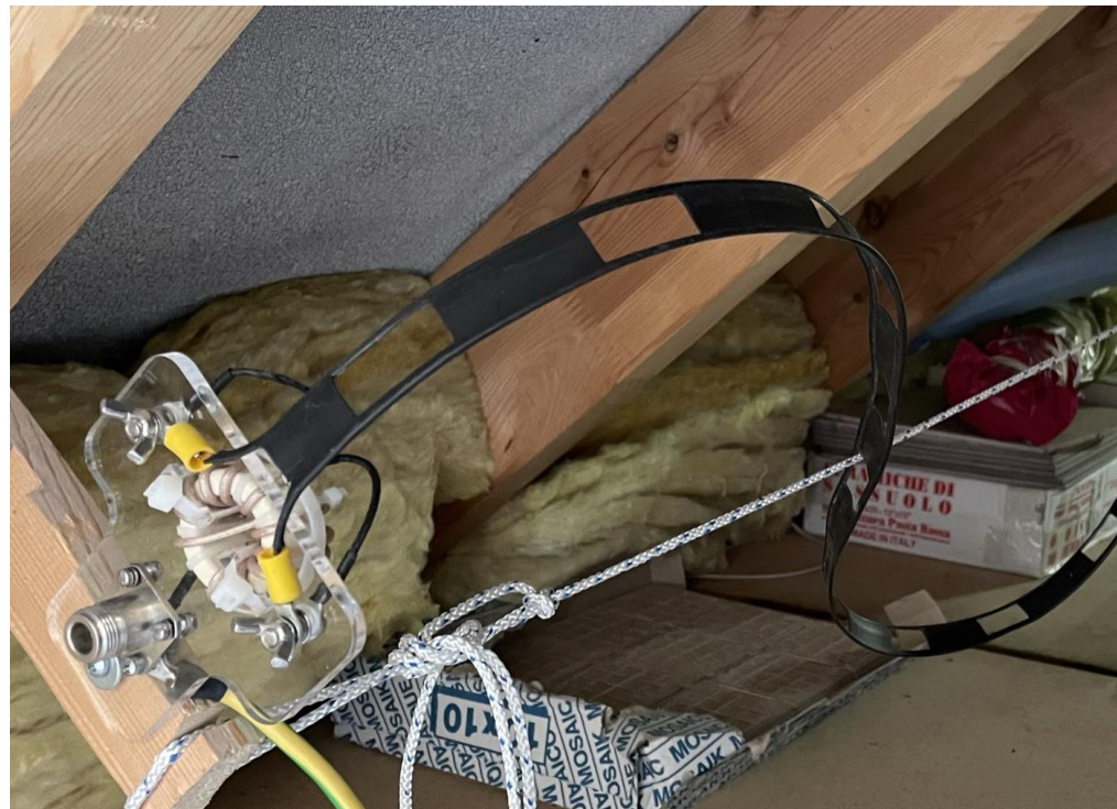
Zweidrahtleitung isoliert unter Dach eingeführt – Erdung am Balun
