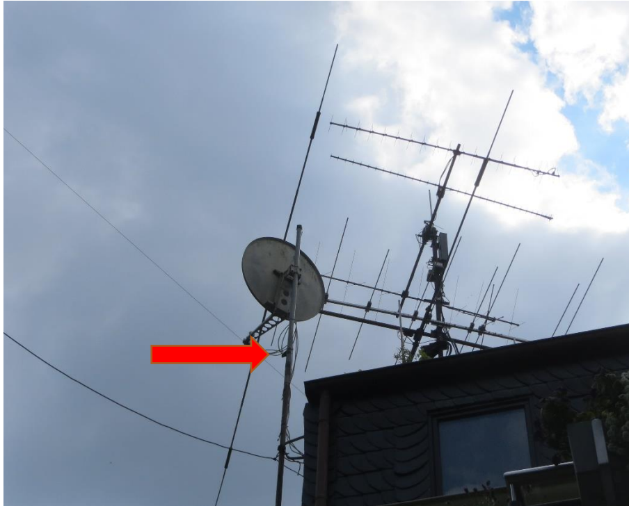
Bild 6: Sat-Anlage und AFU-Antennen
